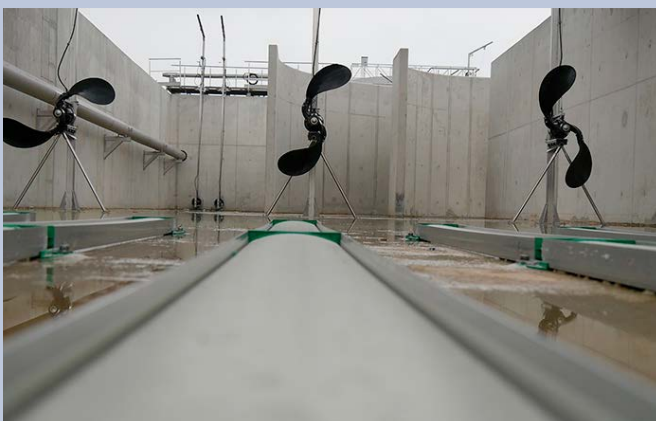
Einbau von Grundfos Strömungsbeschleunigern für die Modernisierung der Abwassertanks im polnischen Tomaszów.
